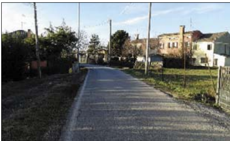
NEL MIRINO Via Argine Adigetto, la strada presa di mira dai malviventi
